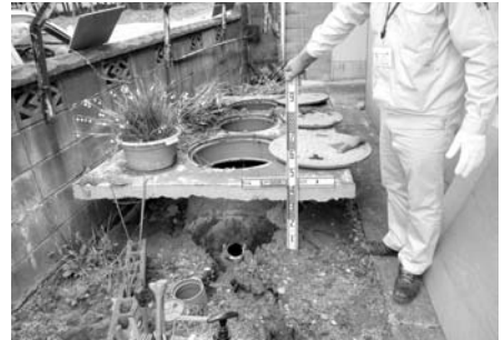
全損と判断される浄化槽の状況(いわき市)
