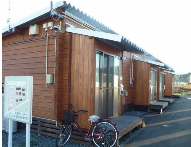
写真-1 仮設住宅(木造建築の例)
