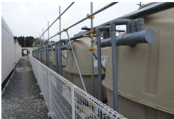
写真-8 ポンプ槽から流入口に接続 (⑤のパターン)
