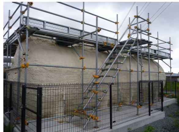
写真－５ 仮設住宅浄化槽 (保温対策及び歩廊対策完了)
