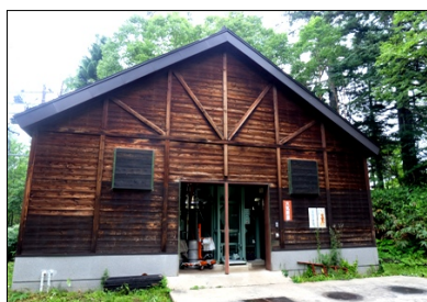
写真－１ 汚泥処理施設（外観）
