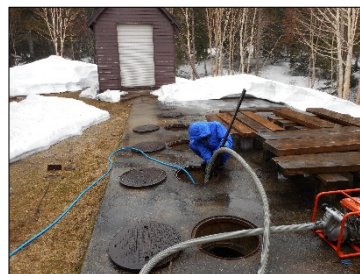
写真－５ 清掃作業状況
